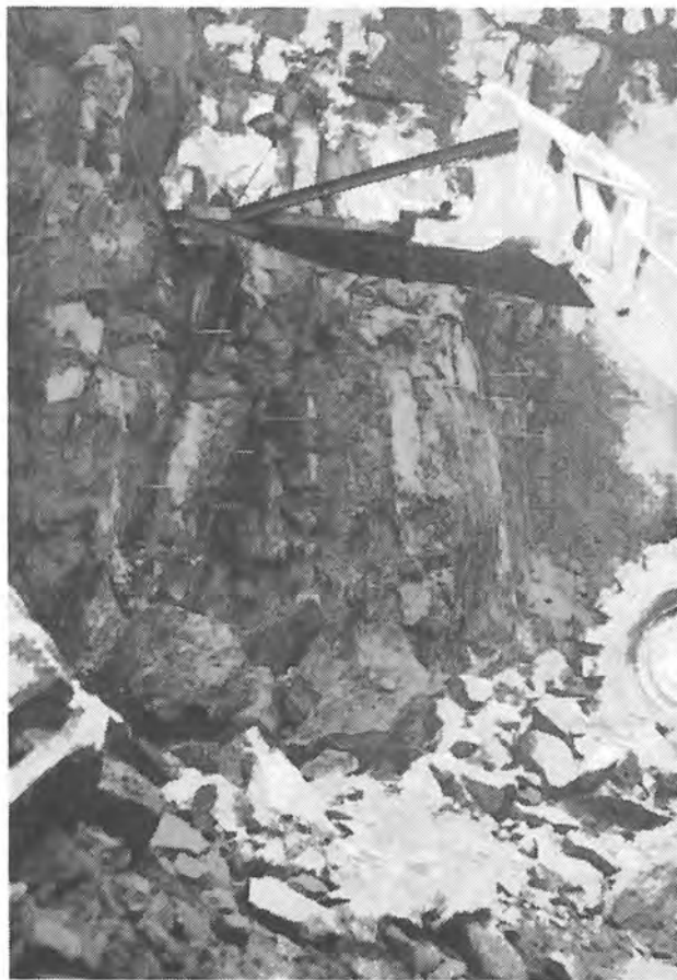
Fig. 19-8. Bolting av påhugg.
