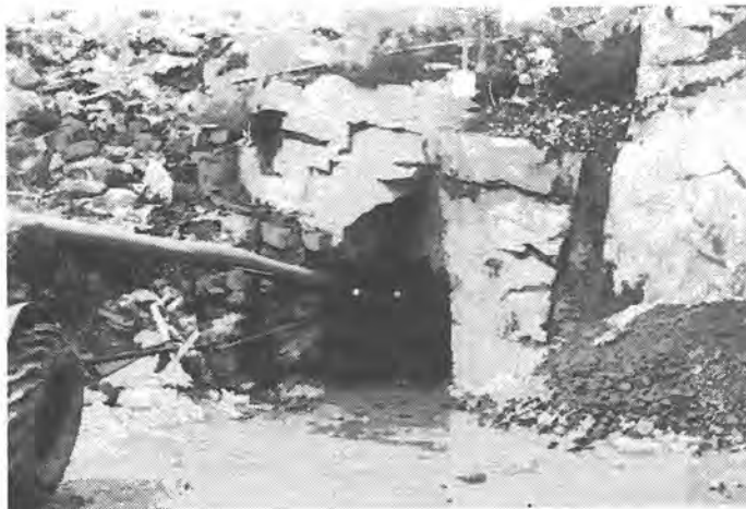
Fig. 20-3 Påhugg i sterkt oppsprukket normarkitt. Blokkene over påhugget er bundet sammen med vertikale bolter.
