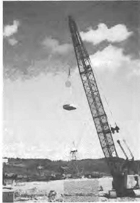
Fig. 27.6a Kran för packning med 40 t fallvikt och 40 m fallhöjd, konstruerad av TLM. Motvikten närmast på bilden är till för att motverka "rekylen" i den höga kranarmen när fallvikten släpps.
