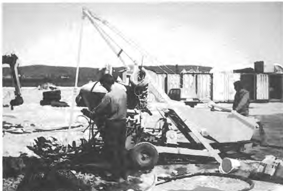
Fig. 9.2. Betongskruen som mobilrigg med heisbar silo.
