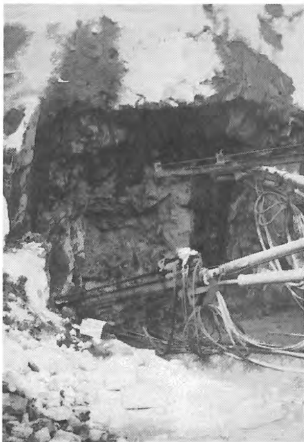
Fig. 19-9. Påhugget etter at sikring er utført og undre halvdel av salven sprengt.
