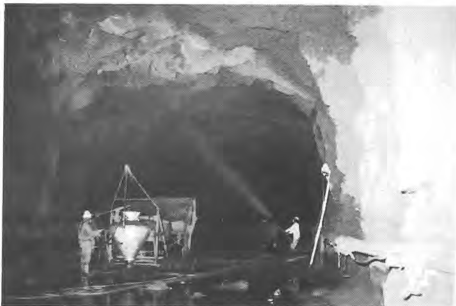
Fig. 9-1. Sprøyting med SEM betongskru.
