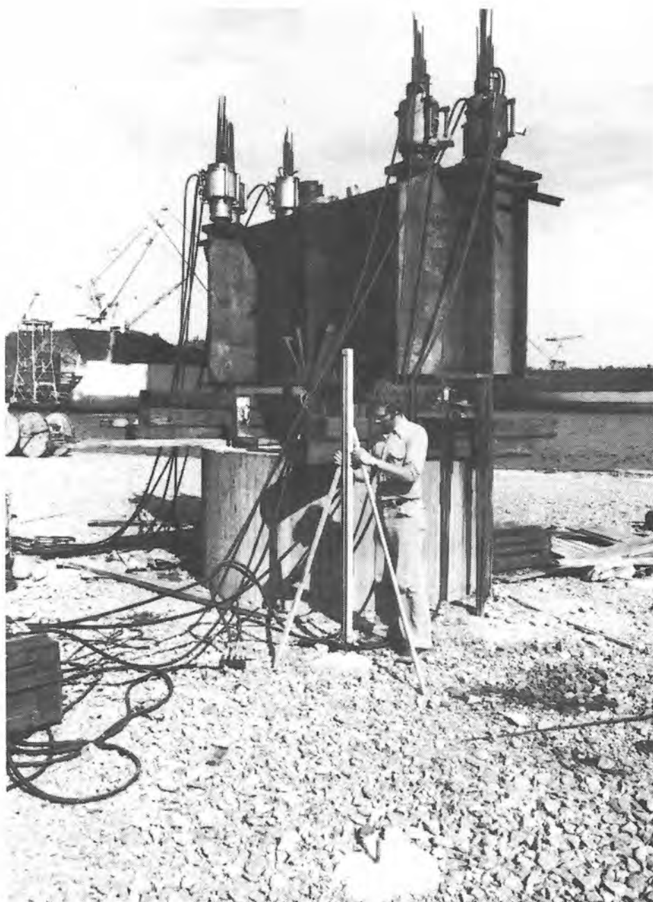
Fig. 27.9 Belastningsförsök med 2,3 m cirkulär, styv betongplatta. Mothållsbalken är förankrad i berg med fastinjekterade vajerstag.
