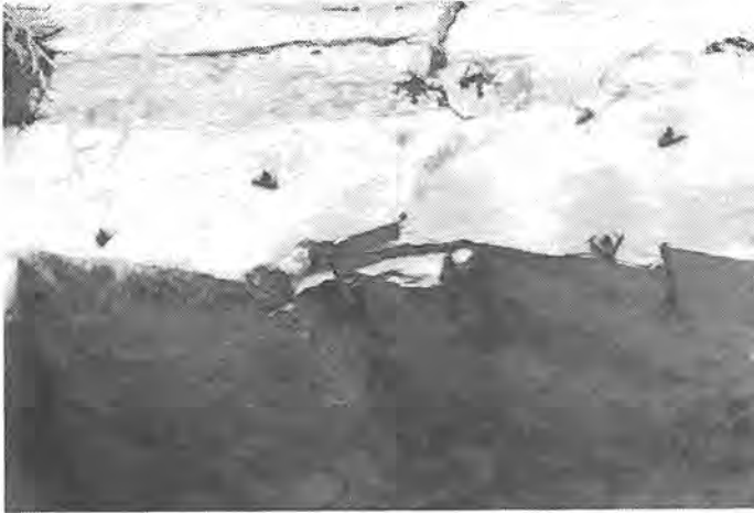
Fig. 20-2 Lange, forspente, innstøpte bolter i benket Drammensgranitt.
