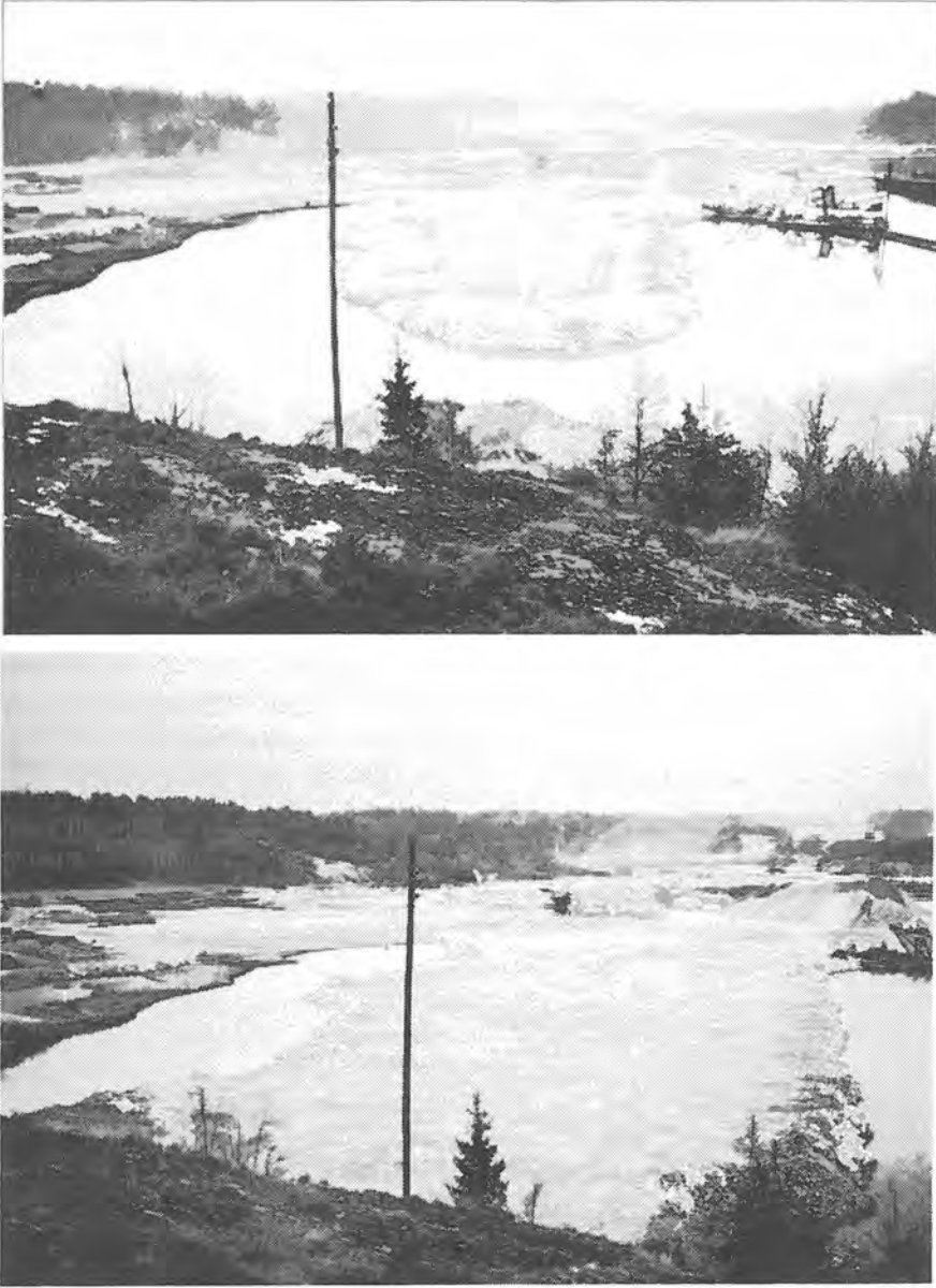
Fig. 27.5a Sprängstensbarriären i det närmaste utbyggd. En ränna har lämnats för att medge pråmtippling av fyllningsmassor innanför barriären. b Sprängstensbarriären fullt utbyggd.
