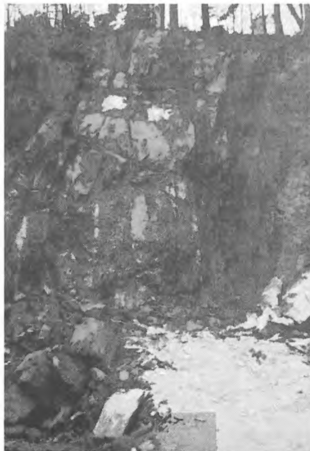
Fig. 19-7. Ferdig ryddet påhuggsområde for adkomst-tunnel ved Rygene kraftverk.
