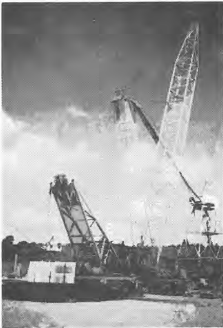
Fig. 27.6a Kran för packning med 40 t fallvikt och 40 m fallhöjd, konstruerad av TLM. Motvikten närmast på bilden är till för att motverka "rekylen" i den höga kranarmen när fallvikten släpps.
