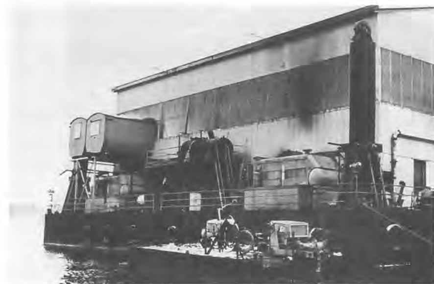
Fig. 11—5 Kompressoranlegg og hvilebrakker på "Trym".
