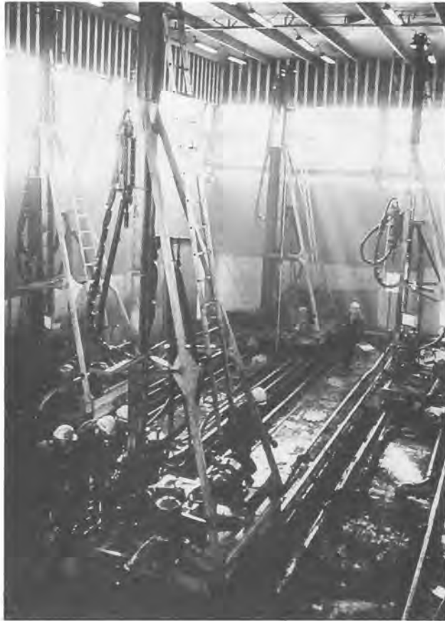
Fig. 11—6 Borriggene montert i hus på flåten.
