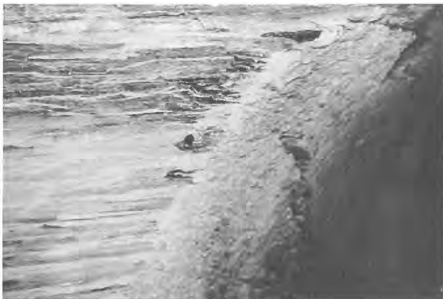
Fig. 5—7. Bergartsstrukturen i sprengt og boret kontur.
