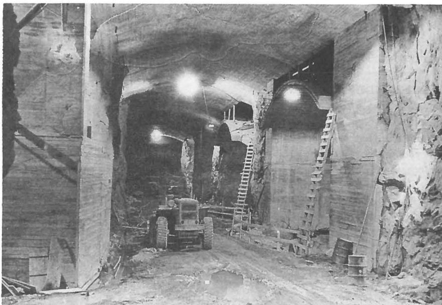
12–7 Sikringsarbeider i fordelingshall syd.
