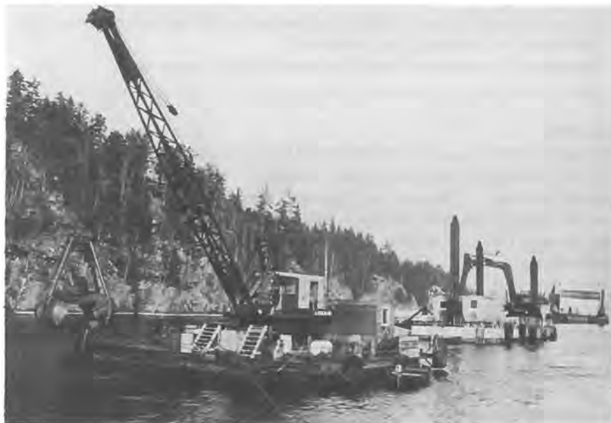
Fig. 11—1 Lorain 86 med grabb montert på flåte.
