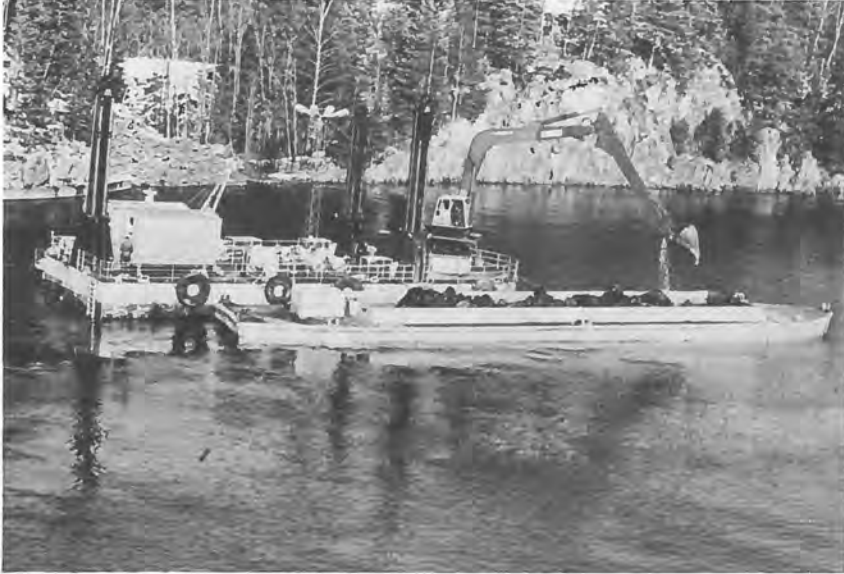
Fig. 11—2 Fastmontert gravemaskin på flåte.
