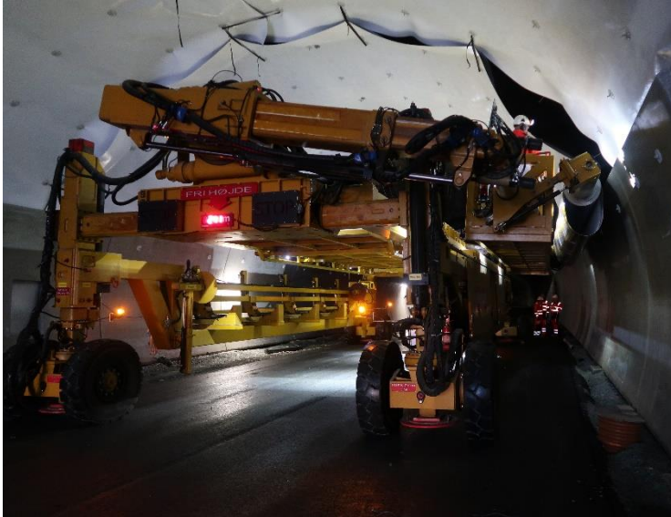
Bilde 7 Maskin for montering av 8 meter bred membran besiktiget av Roar Sve, Amund Bruland og Marcus Fritzøe Lawton
