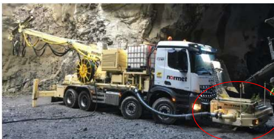
Elektrifisere stasjonær drift – eks betongpumper
