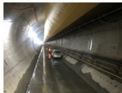
Fullstendig udrenert konstruksjon
