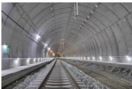
Fullstendig drenert konstruksjon
