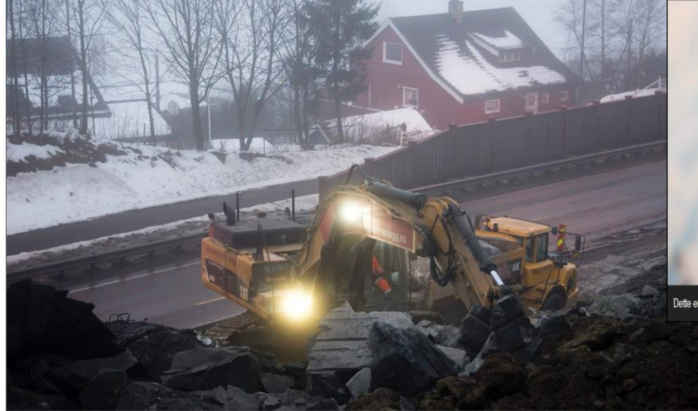
Sprengningsområdet ligger anslagsvis 40 meter unna det røde huset som ble truffet. FOTO: GEIR EGIL SKOG
