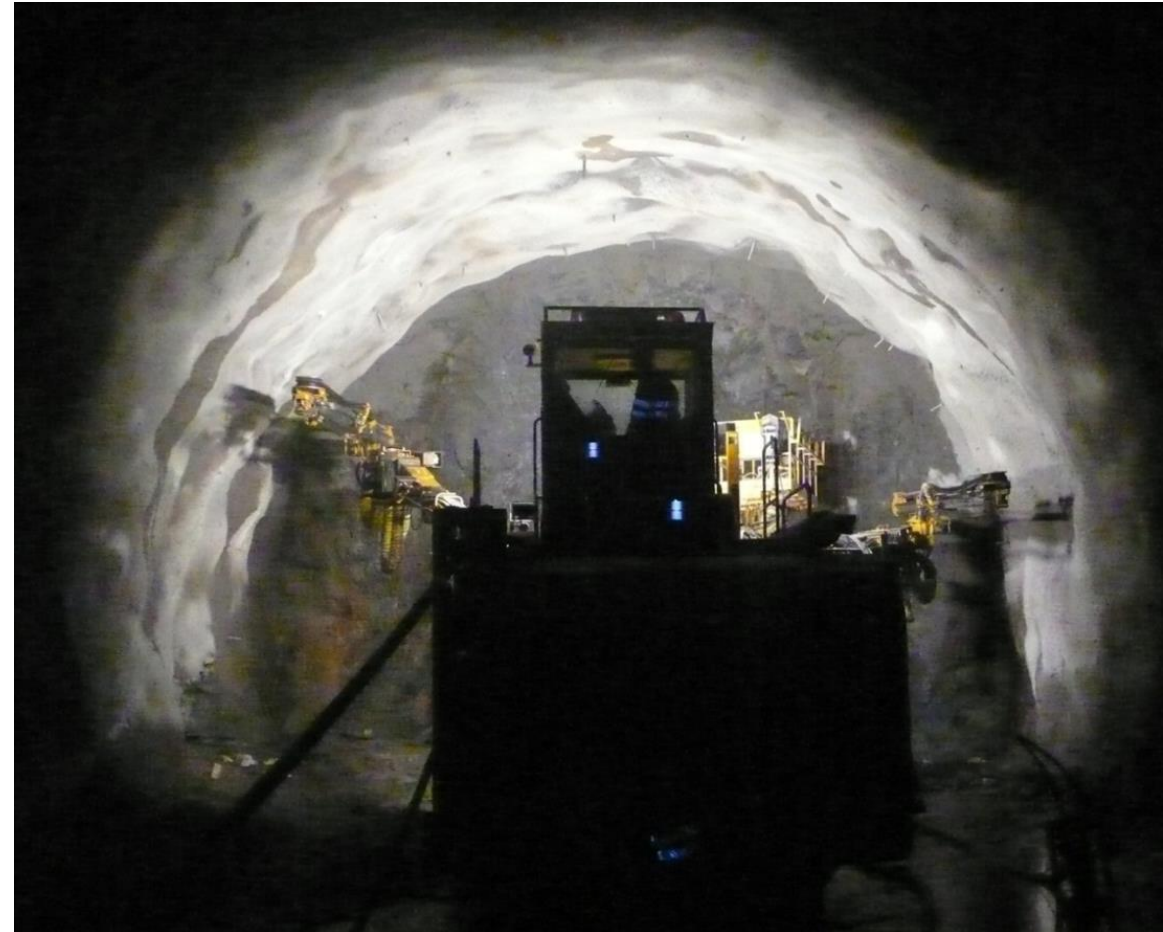
2017 Tjernfjell tunnel - Norge
